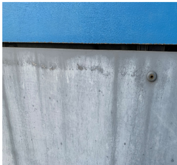
Слайд 2. Разрушение лакокрасочного покрытия высолами на плитах с акриловым грунтом
