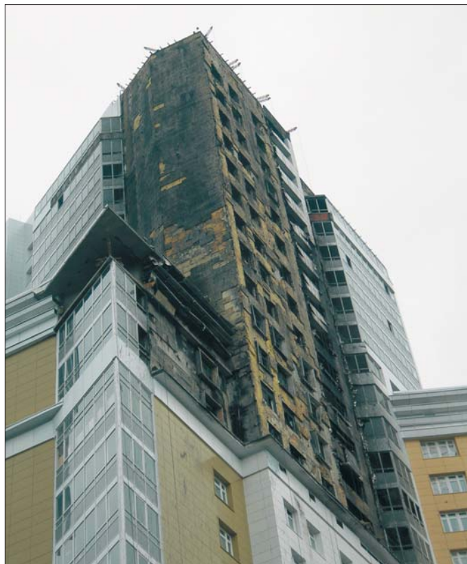
Участки фасада (с 17-го по 30-й эт.) 30-этажного многоквартирного дома после пожара (Москва, ул. И. Бабушкина)
